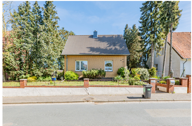
Außenansicht von der Straße
