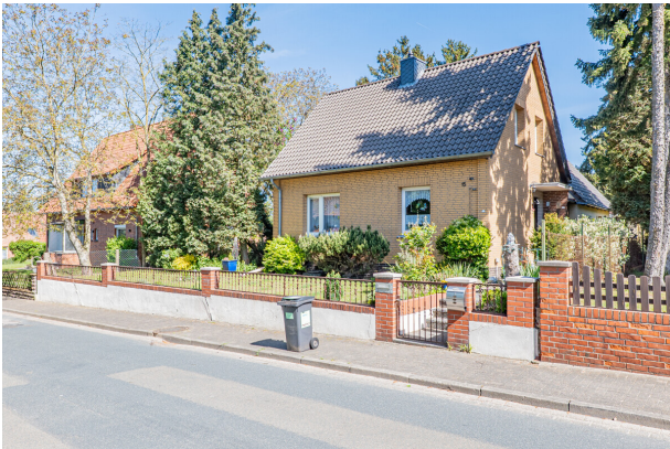
Außenansicht von der Straße
