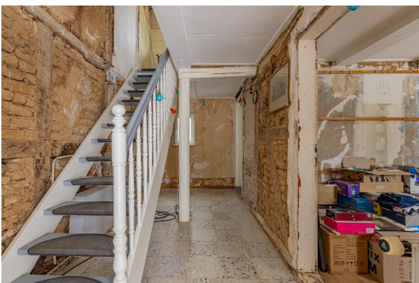
Nebenhaus Links Rohbau
