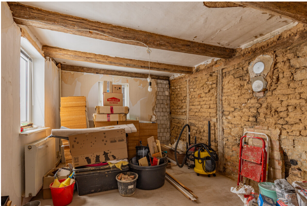
Nebenhaus Links Rohbau
