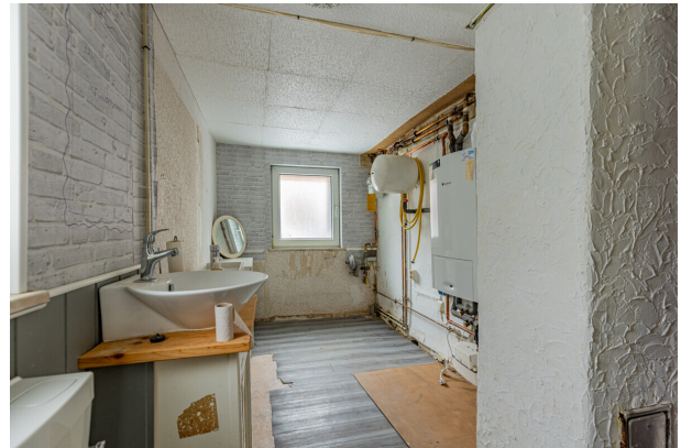
Nebenhaus Links Rohbau
