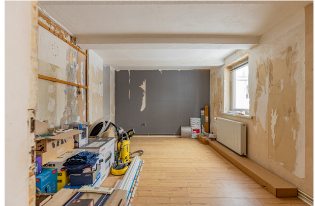
Nebenhaus Links Rohbau
