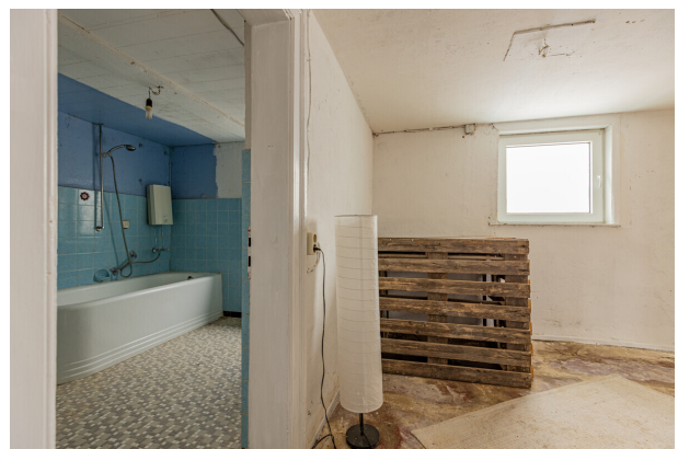
Nebenbau Rechts Rohbau
