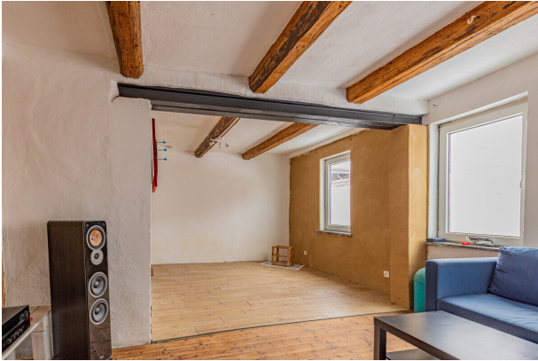
Nebenhaus Rechts Rohbau
